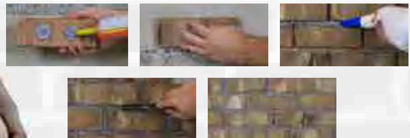
Installation intérieure avec adhésif
